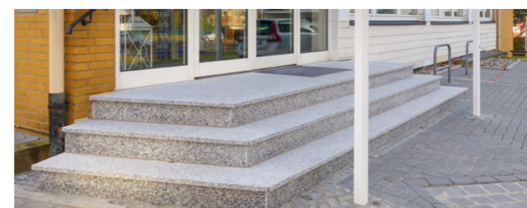
Neue Eingangstreppe Geschäftsstelle
