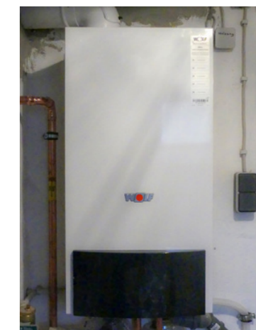
Neue Heizung Kaiser-Wilhelm Str. 28
