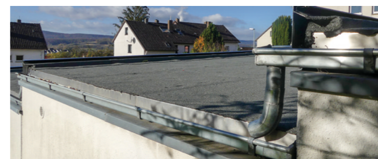
Neue Garagendächer Carl-Heise Str. 6
