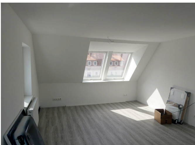
Fußboden- und Malerarbeiten in der Robert-Linnarz-Str. 26+27
