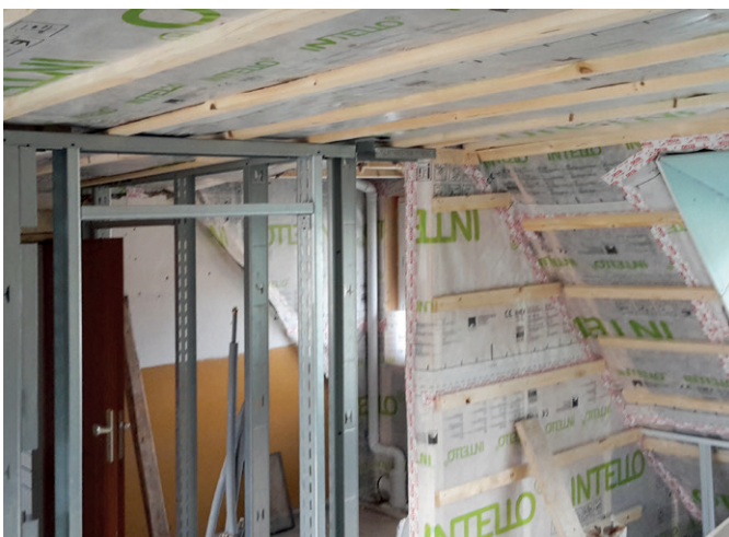
Trockenbauarbeiten DG rechts in der Robert-Linnarz-Str. 26+27
