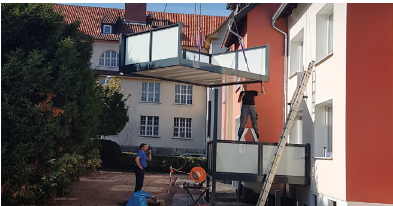
3 Bismarckstr. 14-15 Balkonseite: Montage der Balkone
