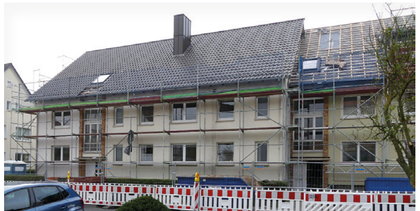
1 Sanierungsarbeiten in der Bismarckstr. 14-15
