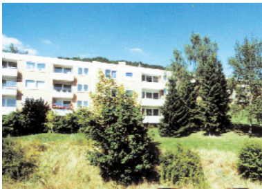
1969, Karl-Krösche-Str. 2/4: zwei neue WOBAU-Häuser mit 25 Wohn-Einheiten
